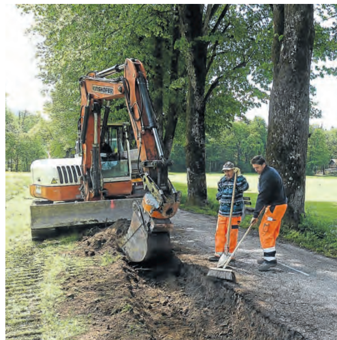
Neue Fußweg-Trasse: Der Großherzogin-Maria-Anna-Weg wird zum Schutz der Bäume von der Lindenallee abgerückt.
